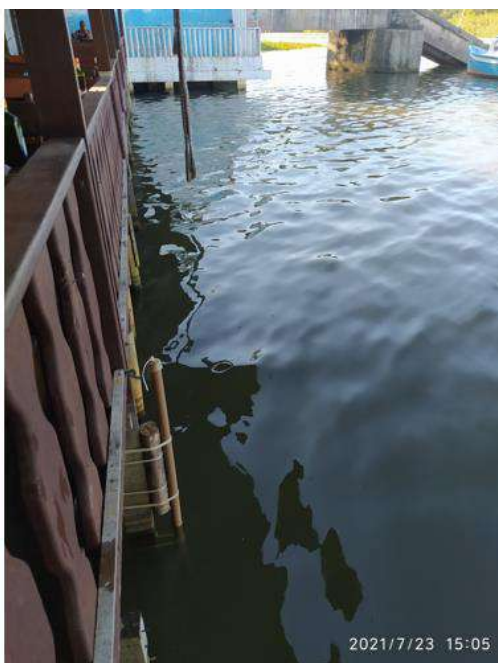
Figura 66 - Instalação de marégrafo na porção de jusante do Rio Jucu.
