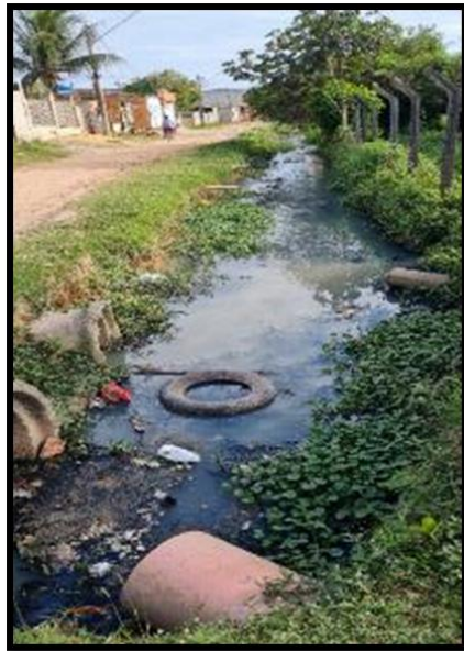
Figura 1.14. Valas de escoamento de esgoto a céu aberto.
